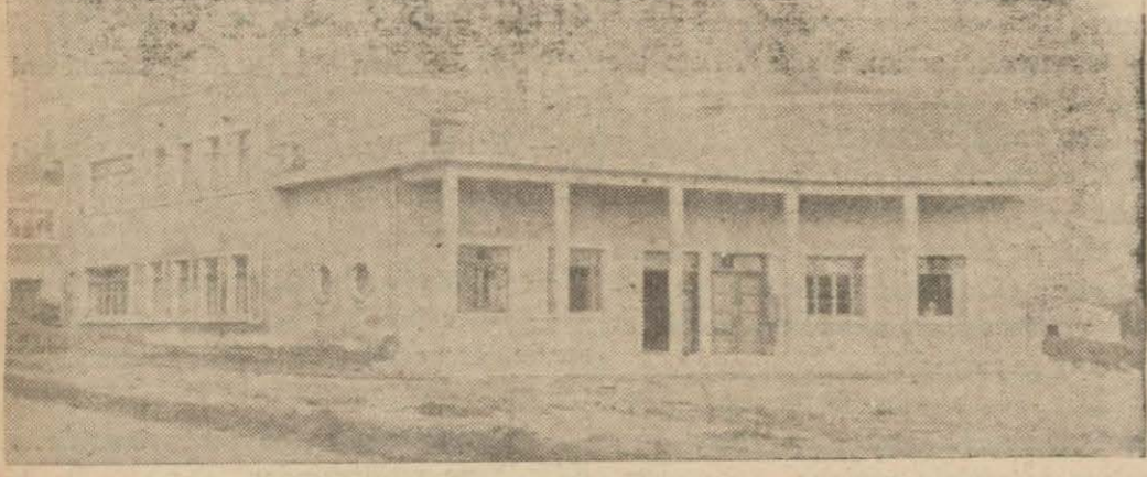
Babaeskide yeni yapılan Halkevi binası
